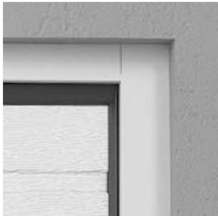
Installées depuis l'intérieur du garage, les montants d'huissérie ainsi que le couvre-joint peuvent déborder le cadre d'une baie, ce qui permet d'installer la porte standard dans une ouverture plus grande.
